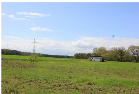
Abb. 11: Trafostation östlich der Grundstückszufahrt
