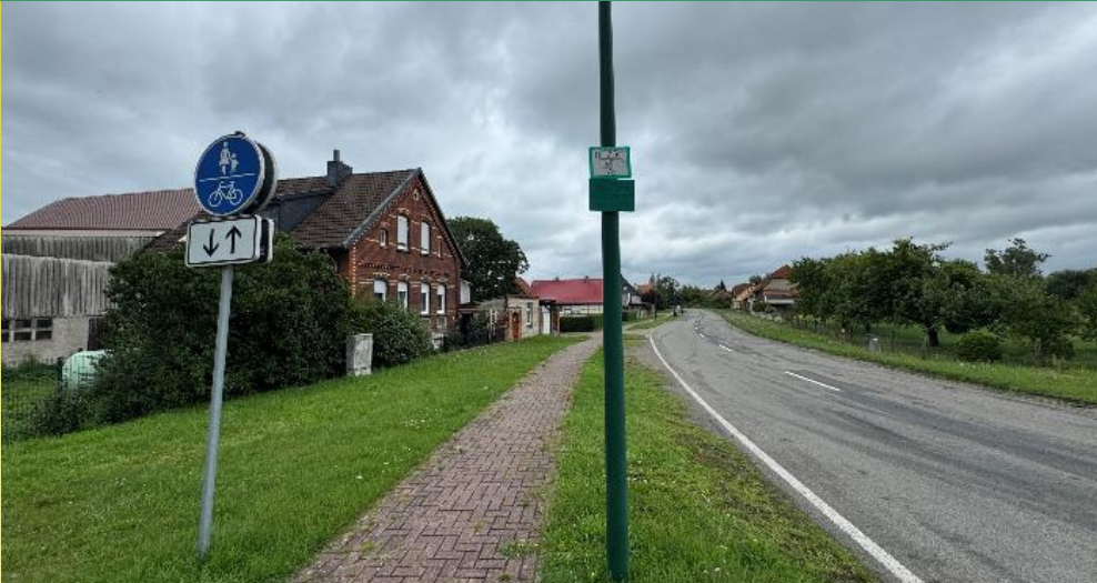
Ausgebaute Nebenanlagen- Ausbaubreiten entsprechend Förderung Dorferneuerung
