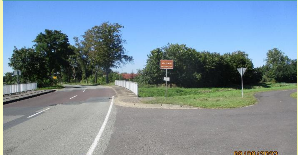
Brücke Allerkanal sowie Anbindung Miesterhorster Straße an Ortsdurchfahrt
